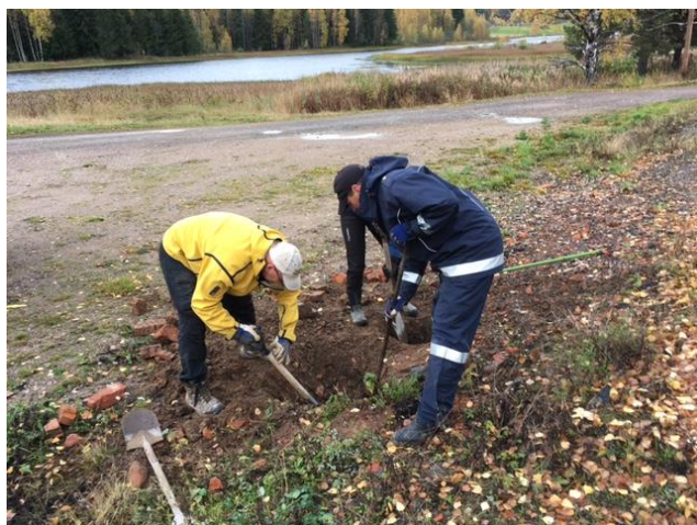
Grävning för anslagstavla
